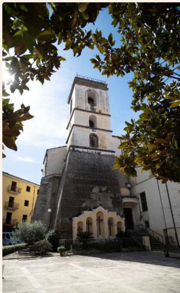
Il campanile di San Lorenzo, con il caratteristico profilo a ventola.
